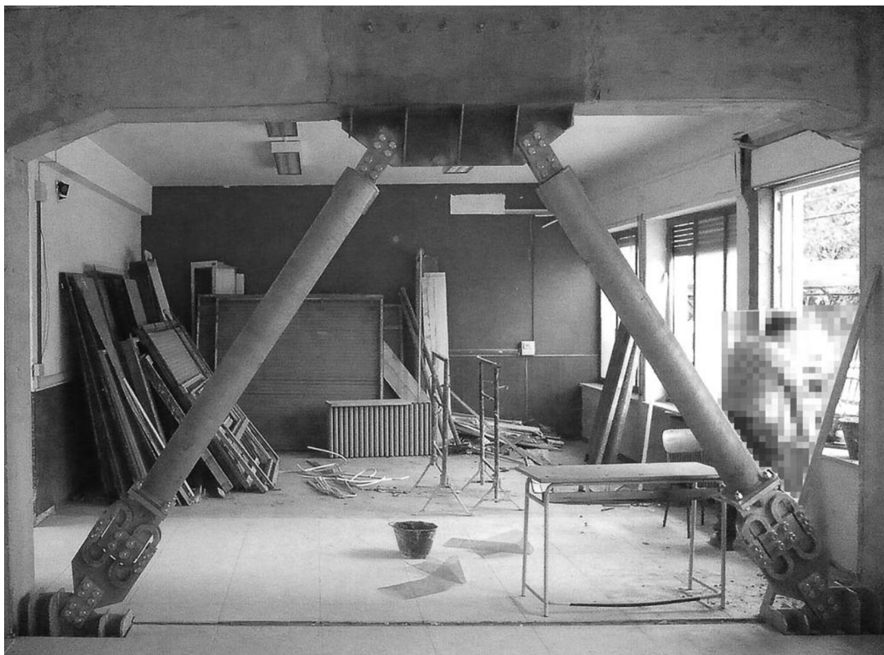
Installazione di controventi dissipativi
