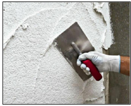
Ripresa di intonaco, rasatura e tinteggiatura
