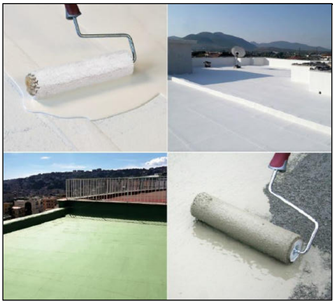
Impermeabilizzazione con guaina liquida da posare a rullo o a spruzzo previa revisione della guaina esistente
