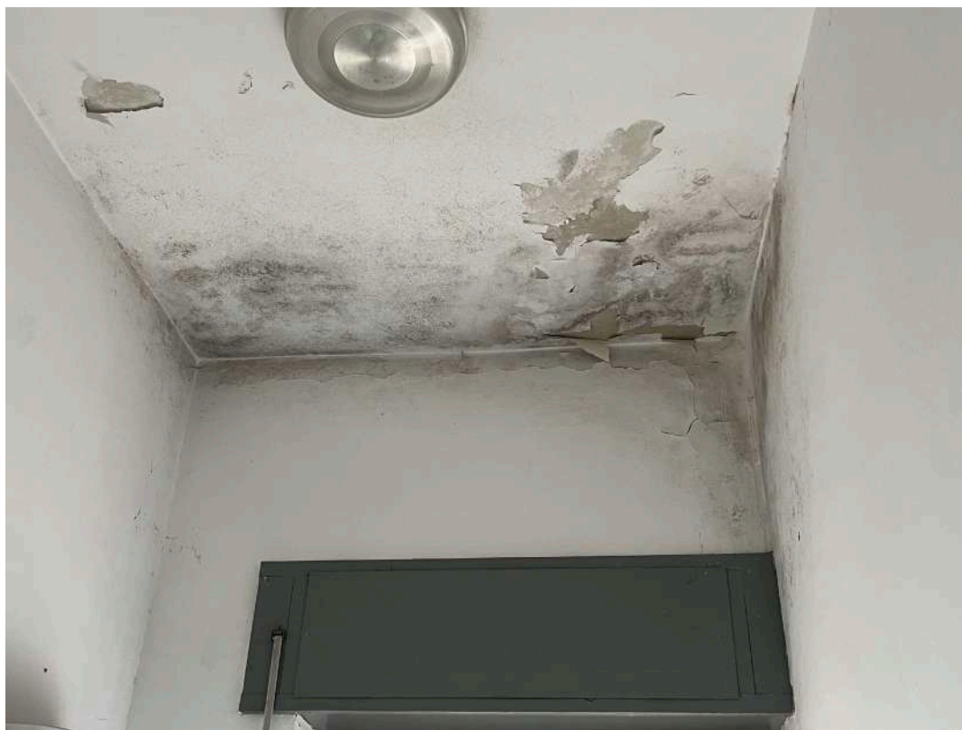
FOTO N.33 : Vista infiltrazione dalla copertura all'interno del Bagno 2
