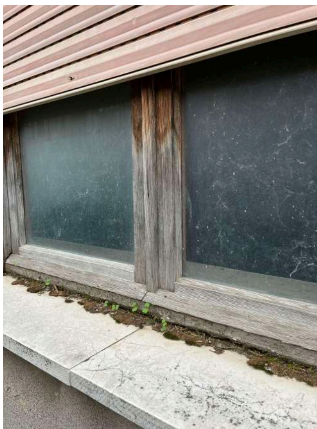
FOTO N.8 : Infissi esterni : stato di degrado
