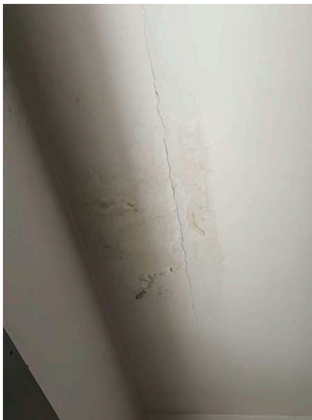
FOTO N.20 –: Vista infiltrazione dalla copertura all'interno della Camera 2
