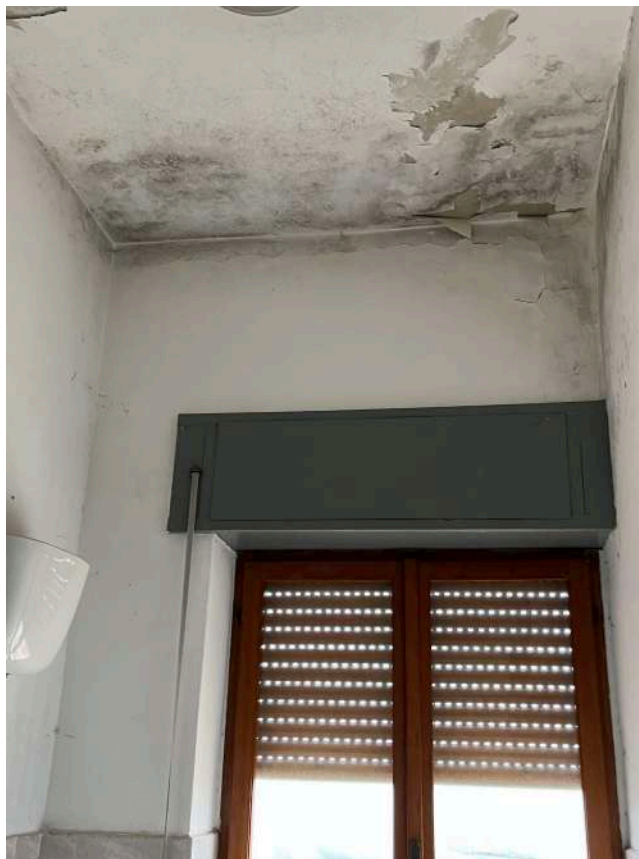
FOTO N.34 : Vista infiltrazione dalla copertura all'interno del Bagno 2
