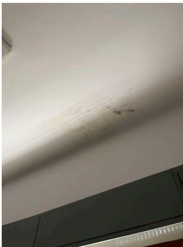
FOTO N.19 –: Vista infiltrazione dalla copertura all'interno della Camera 2
