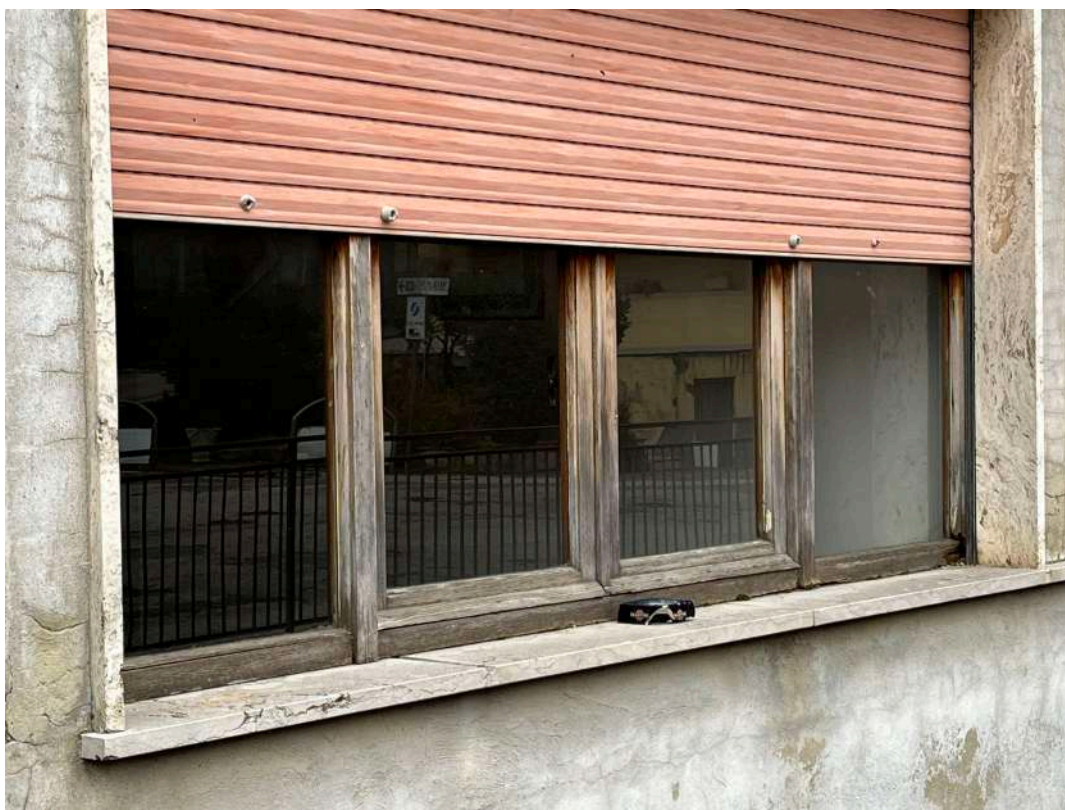
FOTO N.10: Infissi esterni : stato di degrado
