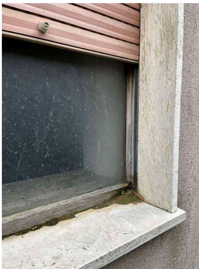
FOTO N.9 : Infissi esterni : stato di degrado
